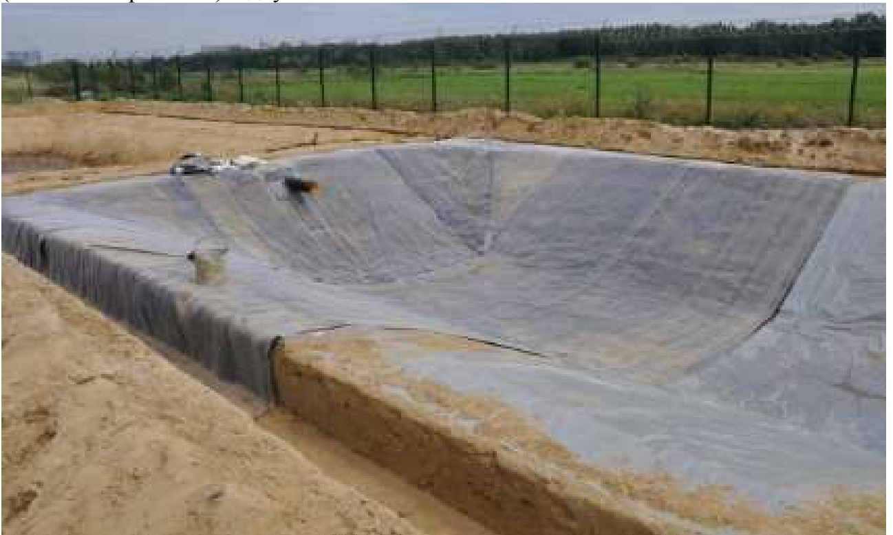
Рис.34 Укладка бентонитовых матов в основании пруда-накопителя
