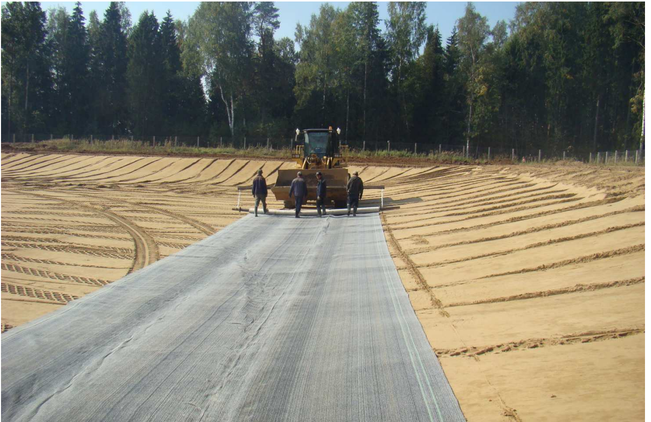
Рис.30 Укладка бентонитовых матов.
