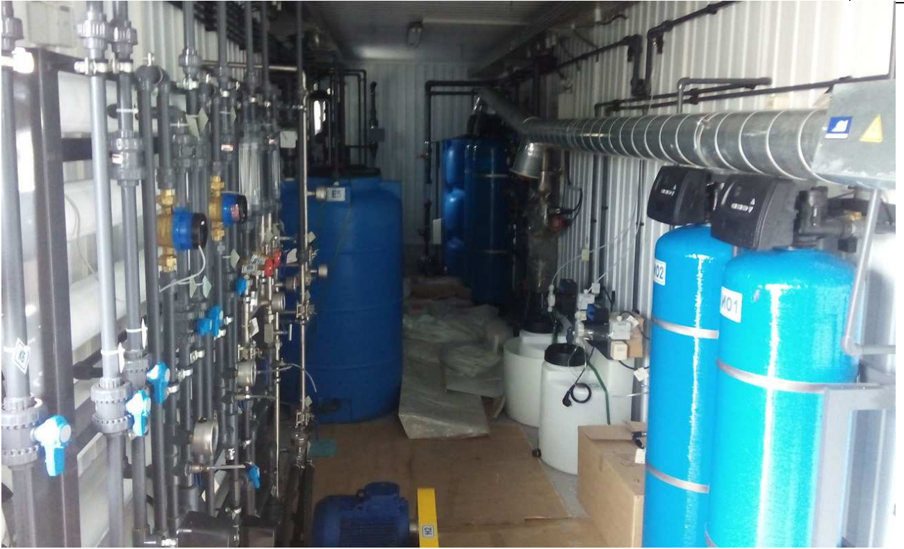
Рис. 36 Ориентировочный вид станции очистки в контейнере
