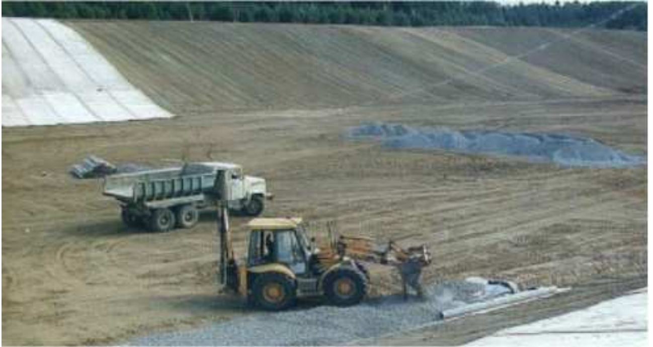
Рис.34 Укладка щебня и перфорированных труб
