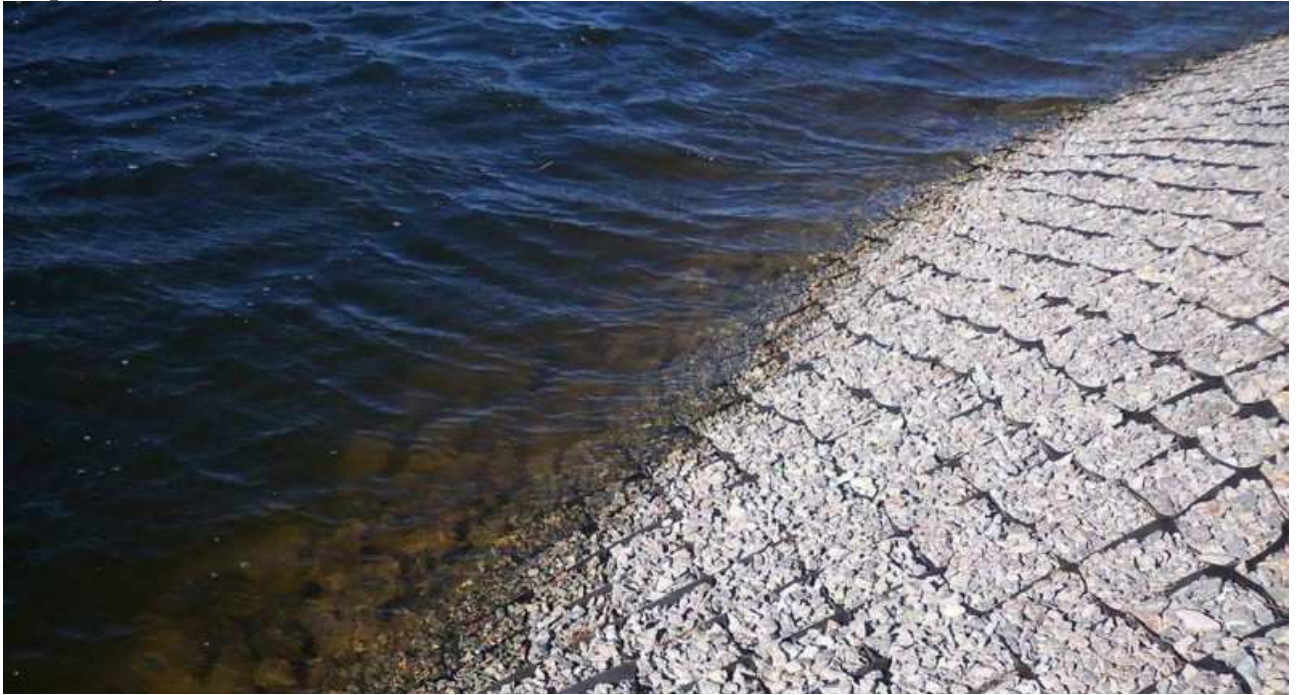
Рис.35 Устройство откосов пруда накопителя
